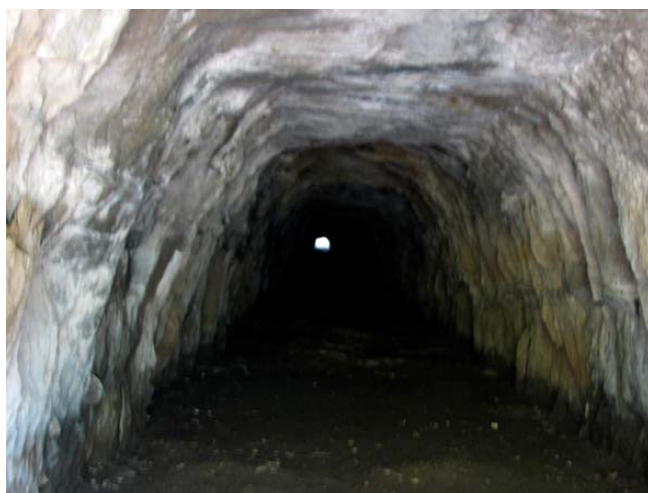
明治20年頃の小野田炭礦から小名浜港へ至る軽便鉄道の湯本地内のトンネル跡(約300メートル)
