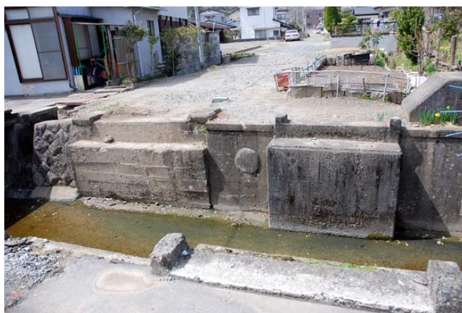
内郷電車線の橋台跡
