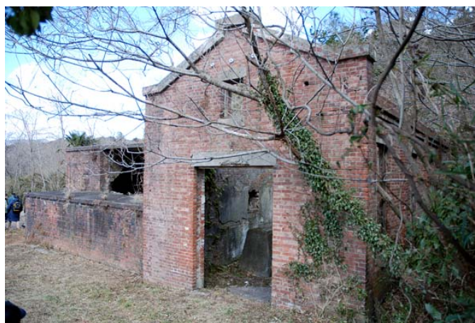
扇風機を設置した建物上屋風景
