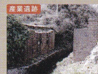
赤レンガの橋台
